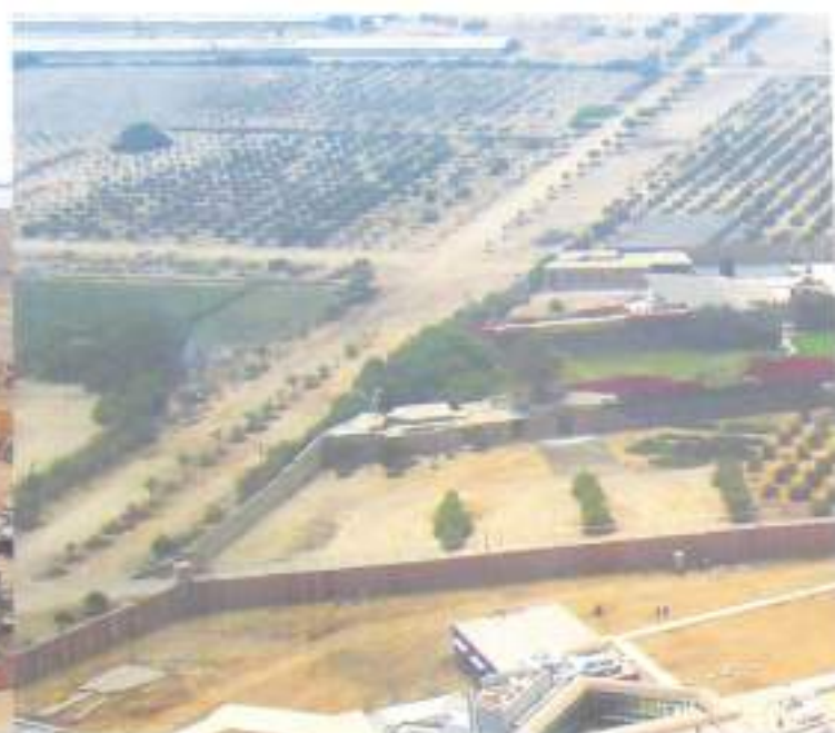
Transportadora de Gas del Perú S.A
